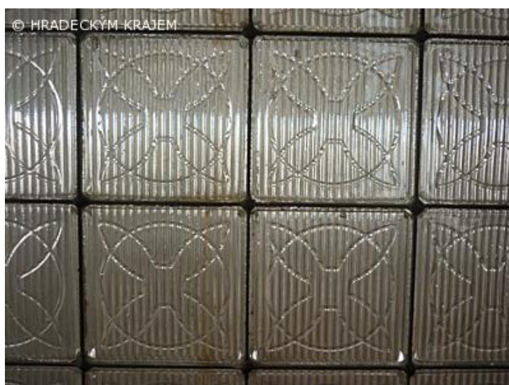
Obr. 11. Wenkeův dům v Jaroměři s detailem skleněné tvárnice
