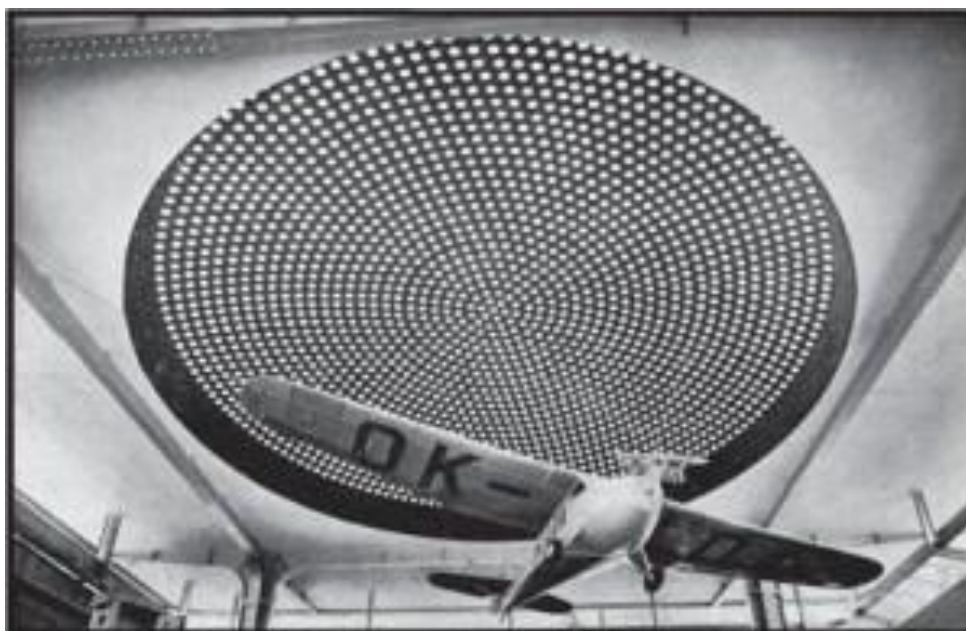
Obr.8. Interiér Československého pavilonu
