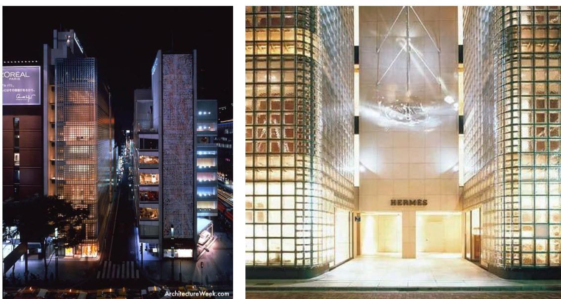
Obr. 14. Budova a průčelí Maison Hermès
