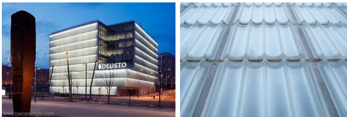
Obr. 17. Univerzitní knihovna v Bilbao s detailem skleněné tvárnice
