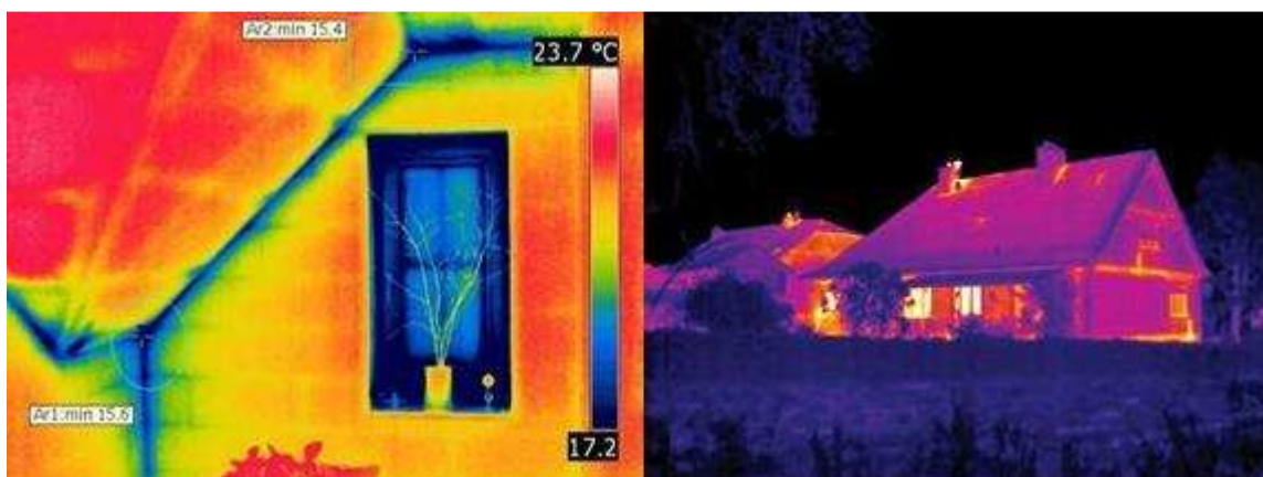
Obr. 32. Termovizní vyhodnocení objektu z interiéru a exteriéru 43
