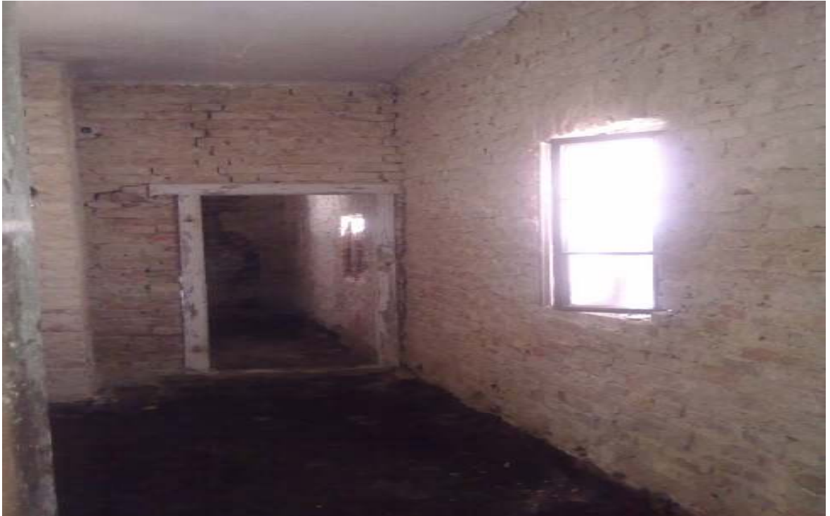
Obr.7: Budoucí sociální zařízení [autor]
