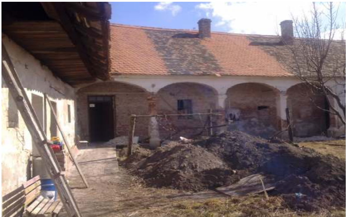
Obr.9: Zahrada, ze které bude zřízen vchod do informačního centra [autor]
