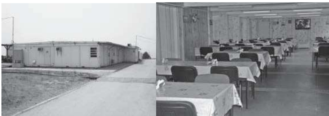
Obr. 5. Jídelní blok a varna sestavená z ubytovacích kontejnerů [10]
