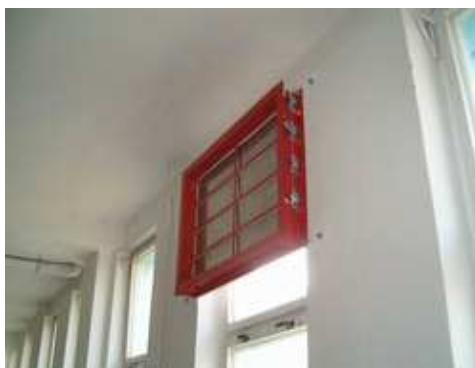
Obrázek 29 - Přetlaková klapka
