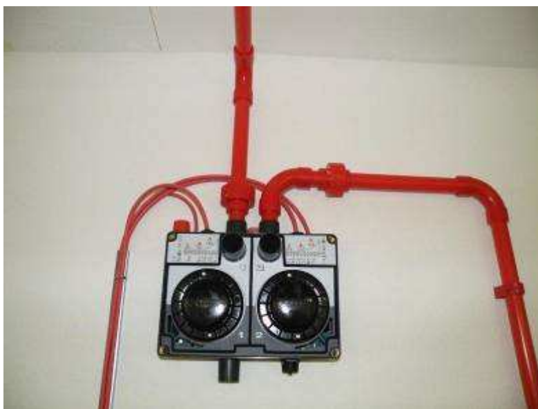
Obrázek 33 - Nasávací kouřové detektory
