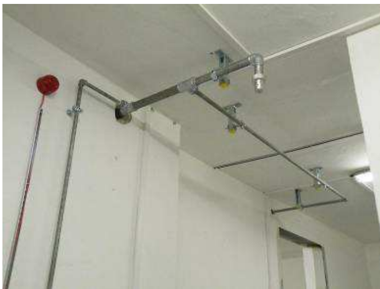
Obrázek 31 - Potrubní rozvody plynu FM 200
