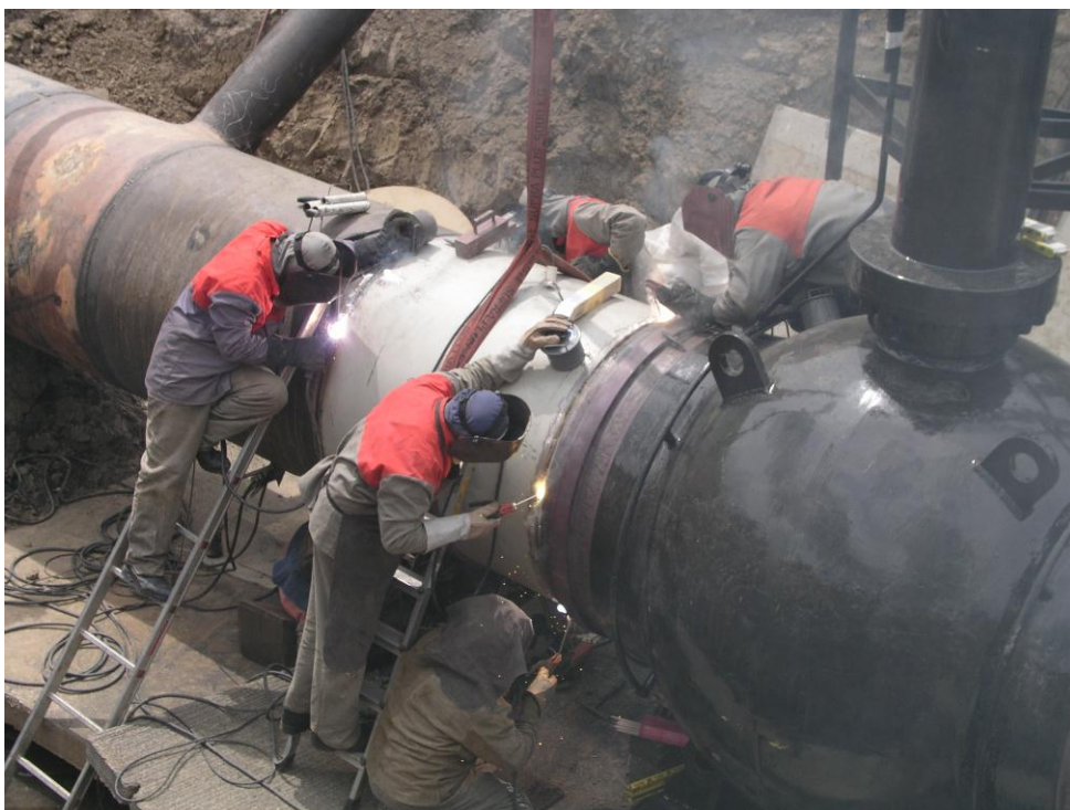
Obr. 8. Výmena potrubia a guľového uzáveru
