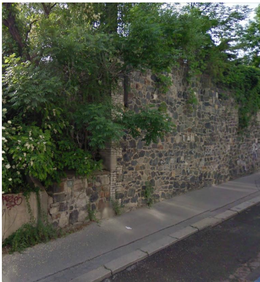
Obrázek 12: Zeď s plotem kolem objektu
