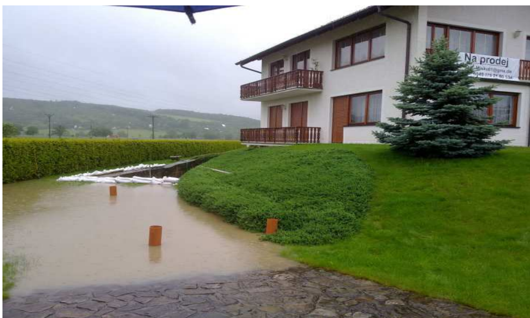
Obr. 3. Havříce – ul. Dolní
