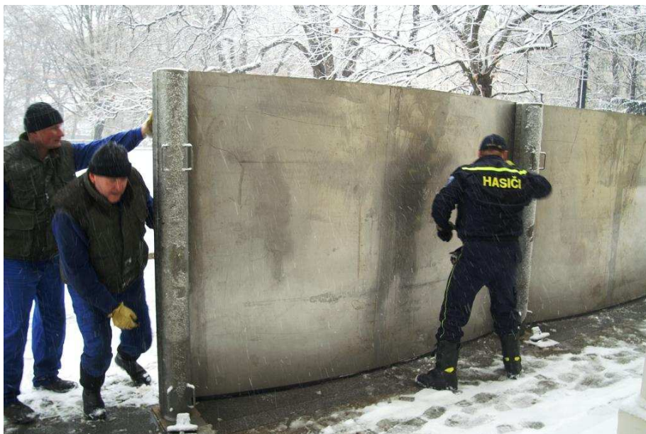
Obr. 24. Instalace hrazení [18]
