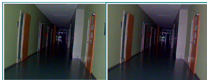
Bodové LED světlo – kamera PELCO (vzdálenosti 1, 10 m):
