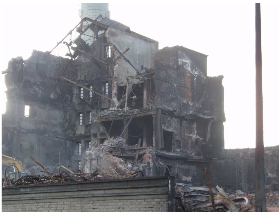
Obr. č. 6 - Po požáru ve firmě Remiva I
