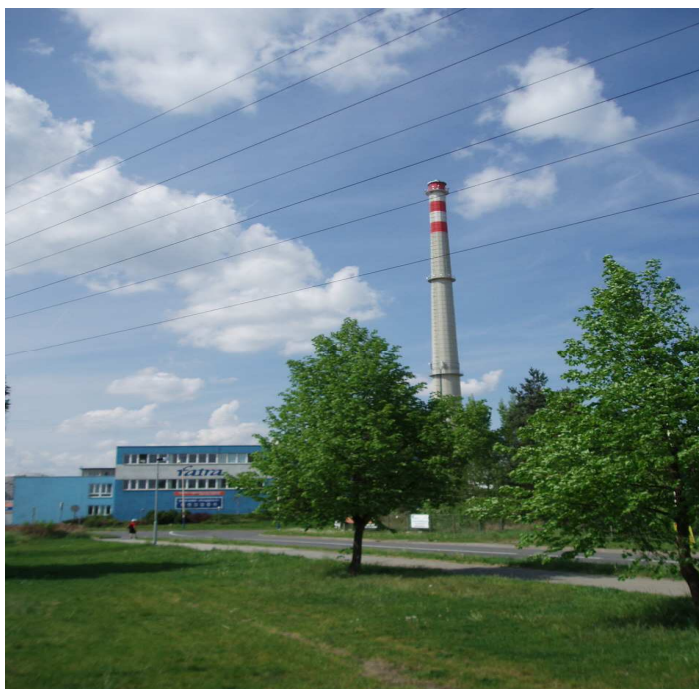
Obr. č. 9 - Výrobní a logistický areál Chropyně
