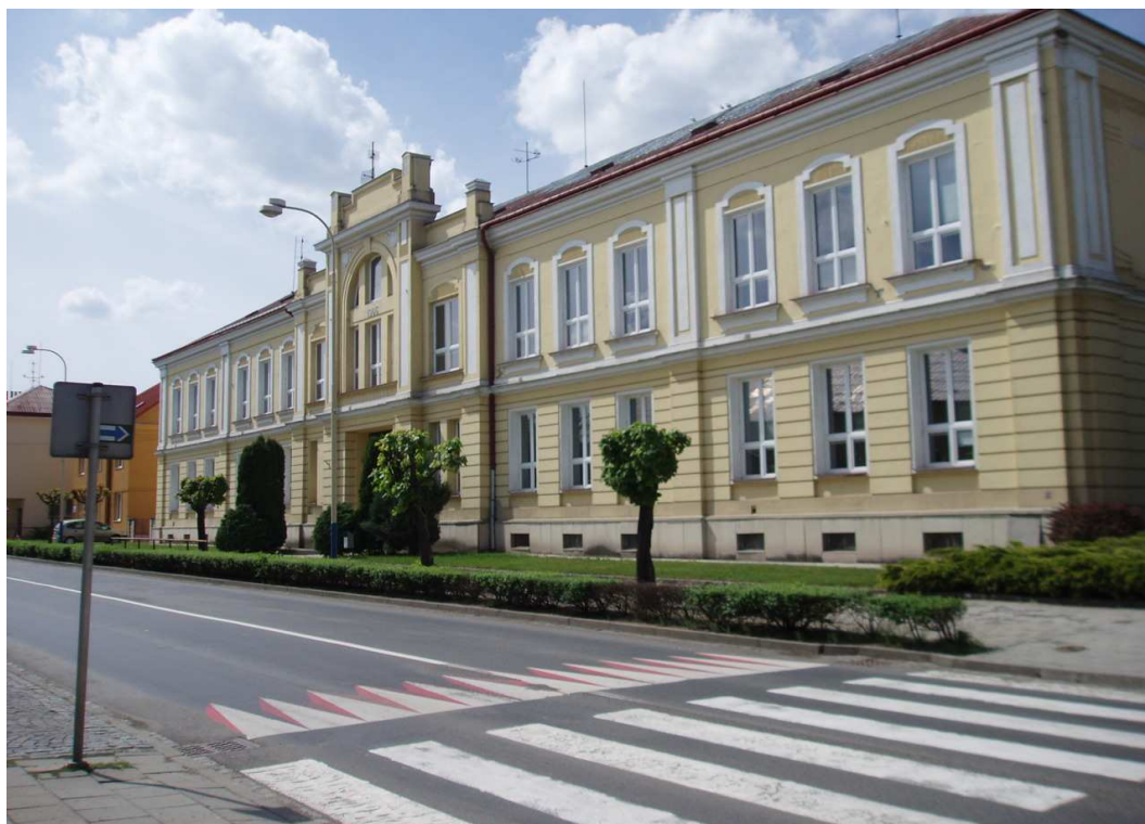
Obr. č. 12 - Základní škola na ulici Komenského
