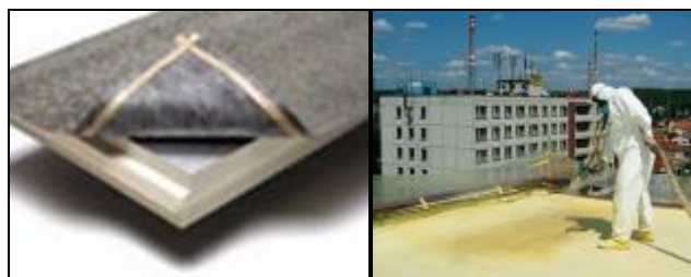
Obrázek 16 Deska z PUR s Al fólií a nástřik střechy PUR
