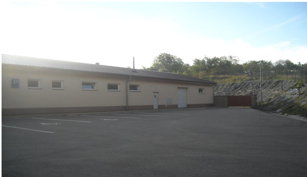
Celkový pohled na budovu bazénu.
