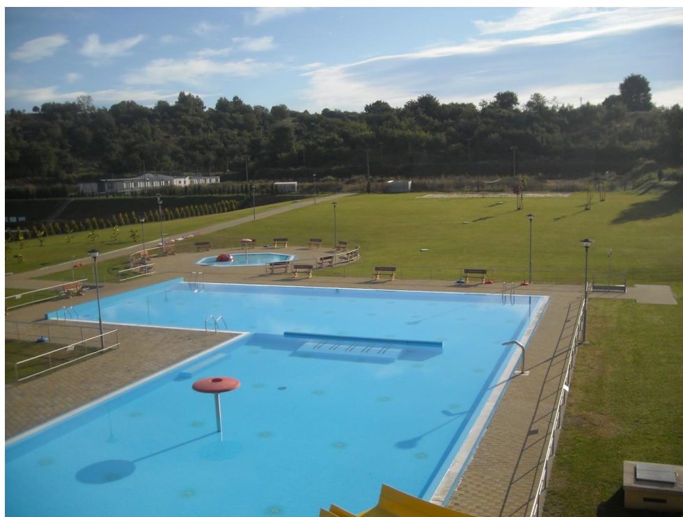
Celkový pohled na venkovní část bazénu.
