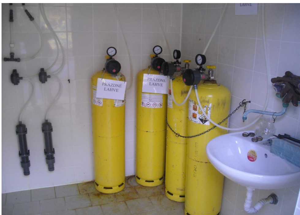
Pohled do vnitřních prostor chlorovny.
