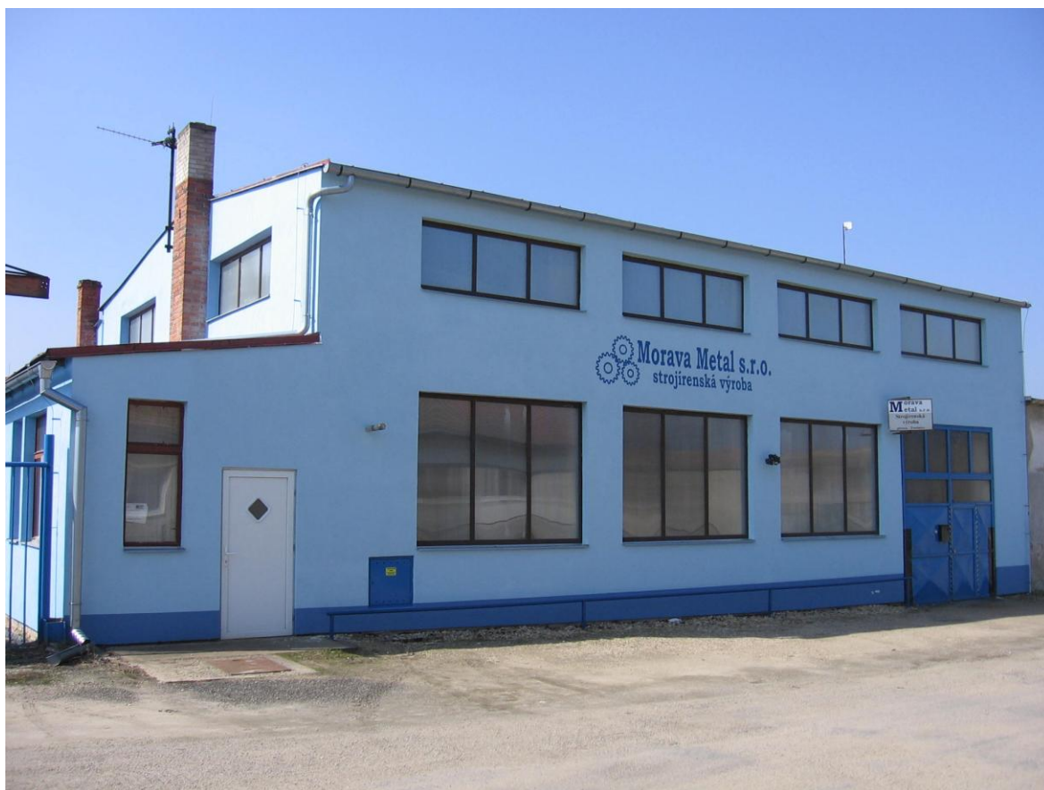
Obrázek 11 Budova společnosti Morava Metal, s. r. o. (vlastní tvorba)
