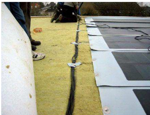
Obrázek 50. Instalace fólie EVALON SOLAR.
