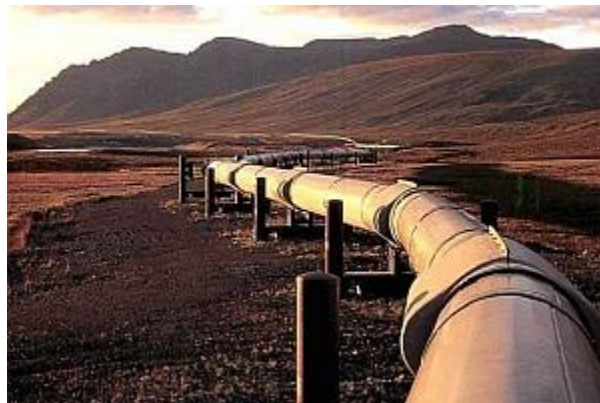
Obr. 10. Potrubná doprava [mkormosiova.web-node.sk]
