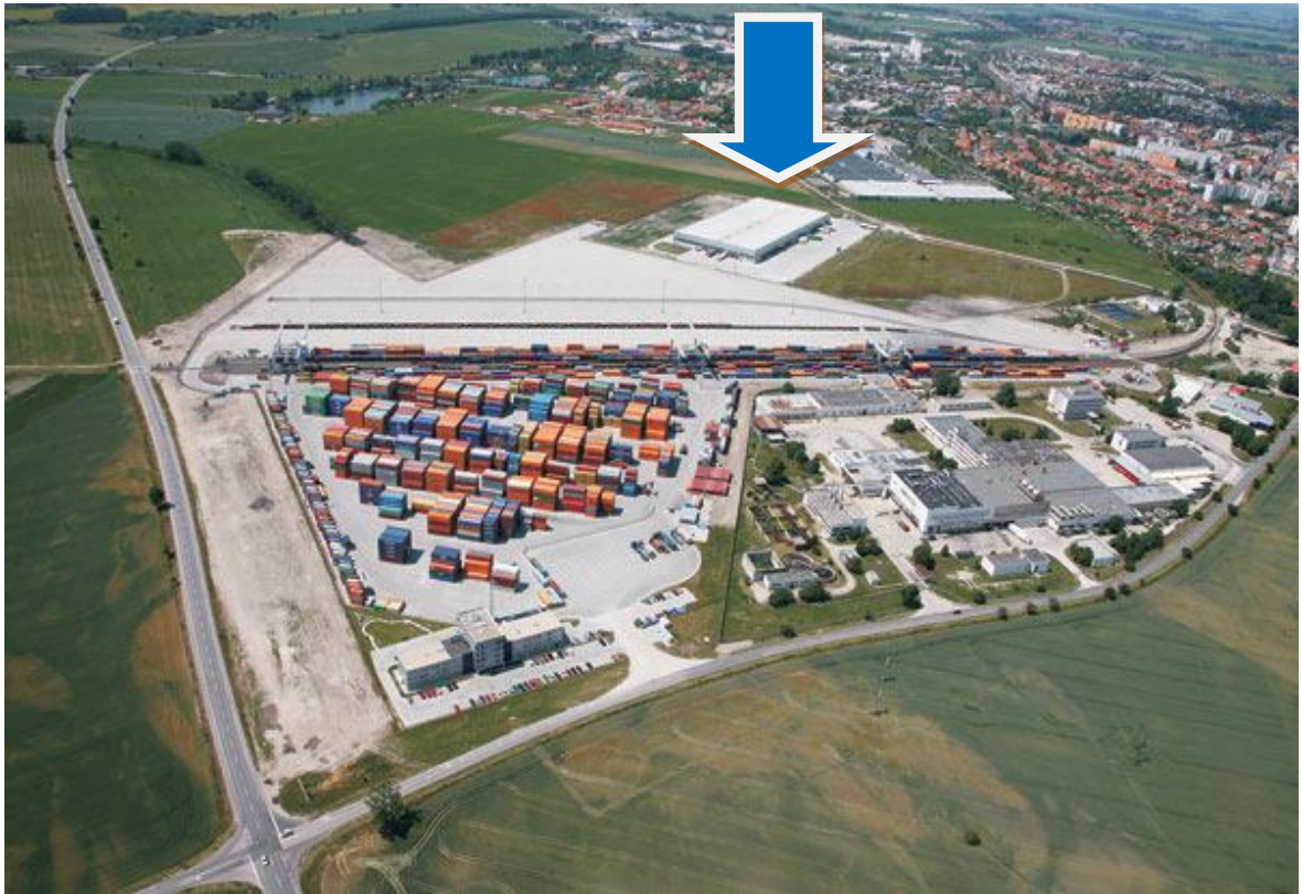
Obr. 29. 1. Etapa Logistického centra Cargo-partner Dunajská Streda [interné podklady spoločnosti]
