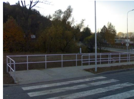
Obrázek 7 Silniční zábradlí (Interní materiály společnosti)
