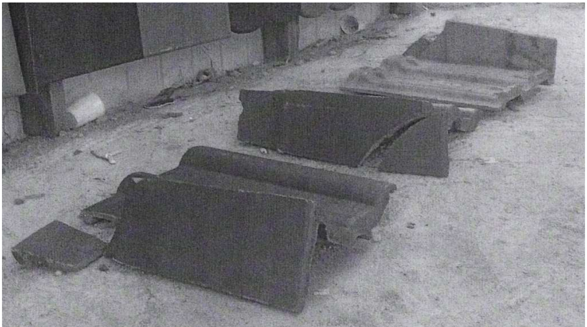
Obr. 9. Poškodené strešné krytiny. Zdroj: [16].
