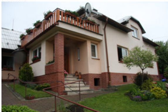
Celkový pohled na objekt rodinného domu
