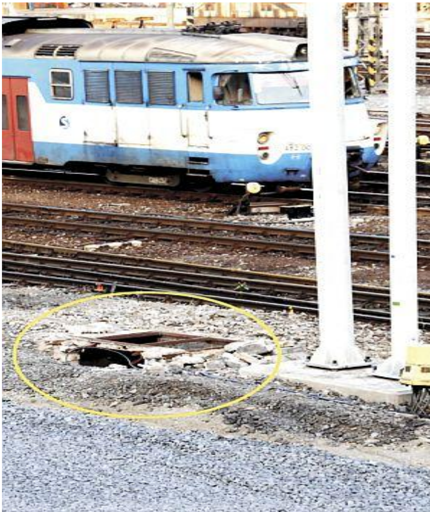
Obrázek 4: Vstup do kabelovodu [8]
