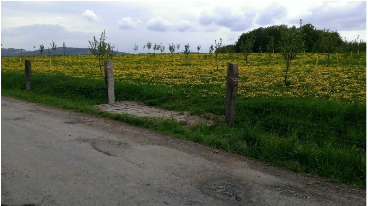
Obrázek 14 Vstup do areálu s chybějící bránou
