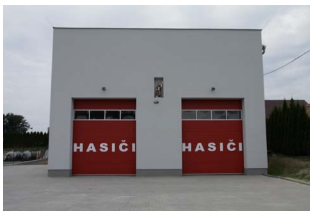
Obr. 2. Polyfunkční budova s hasičskou zbrojnicí
