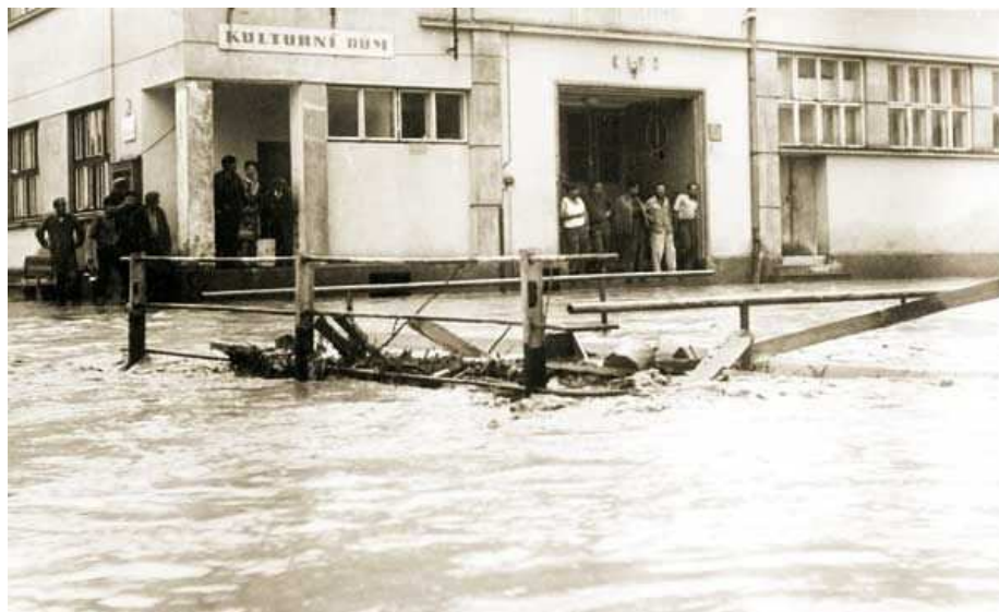
Obrázek 6: Zatopené schodiště kulturního domu, v popředí silniční most
