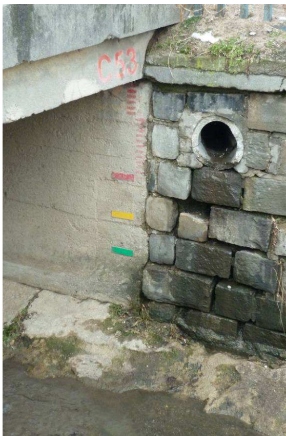
Obrázek 8: Hlásný profil č. 53 pod mostem na silnici I/54
