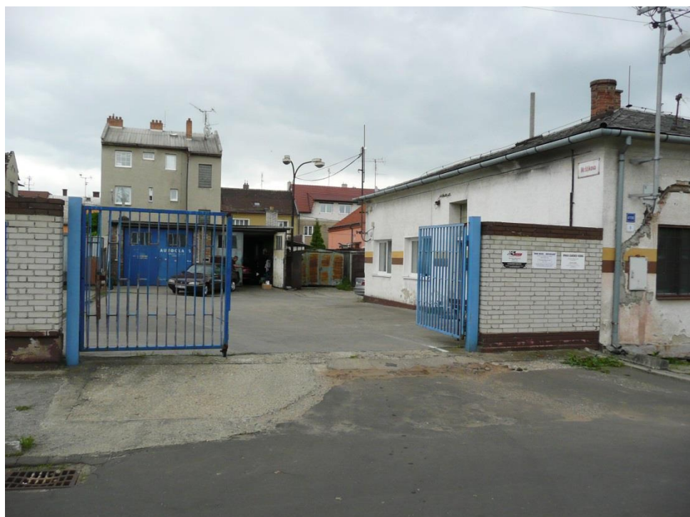
Obr.13 Hlavní příjezdová brána. Zdroj. vlastní
