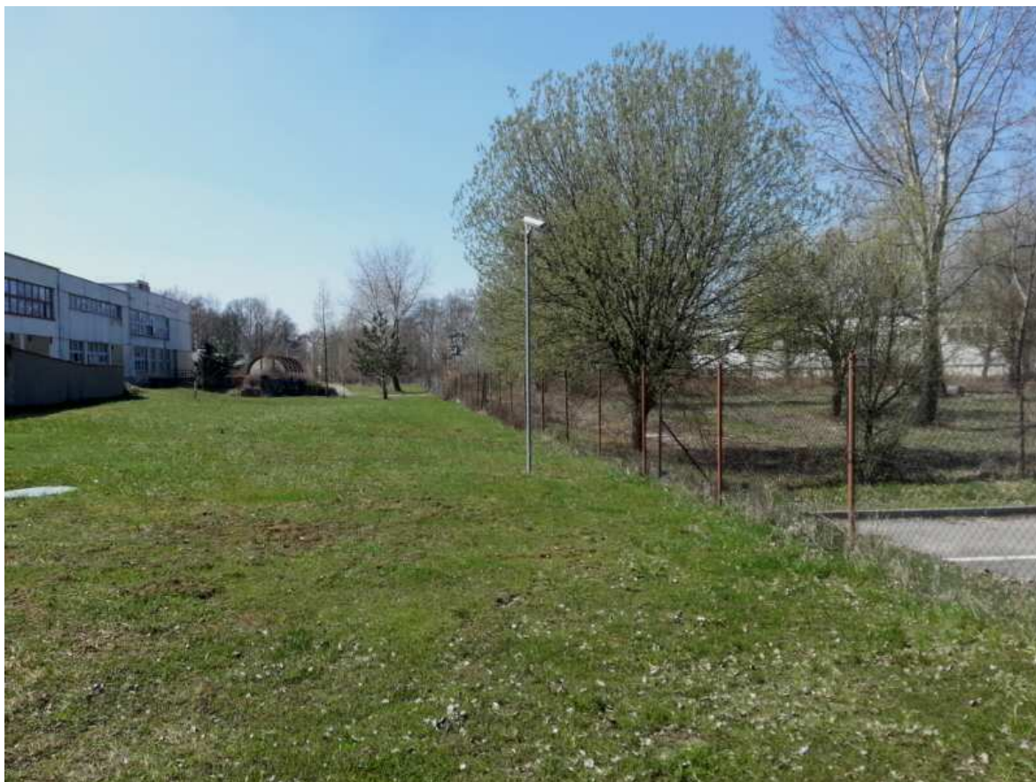
Obr. 9. Oplocení objektu nemocnice s instalovaným kamerovým systémem
