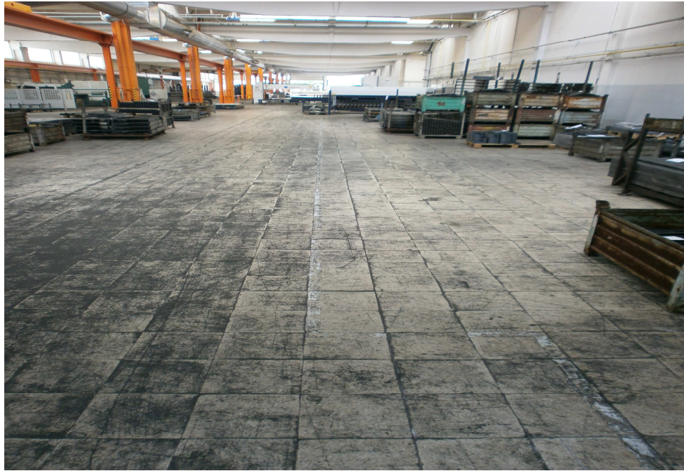
Obrázek 19 Vybledlý nátěr [vlastní zpracování]
