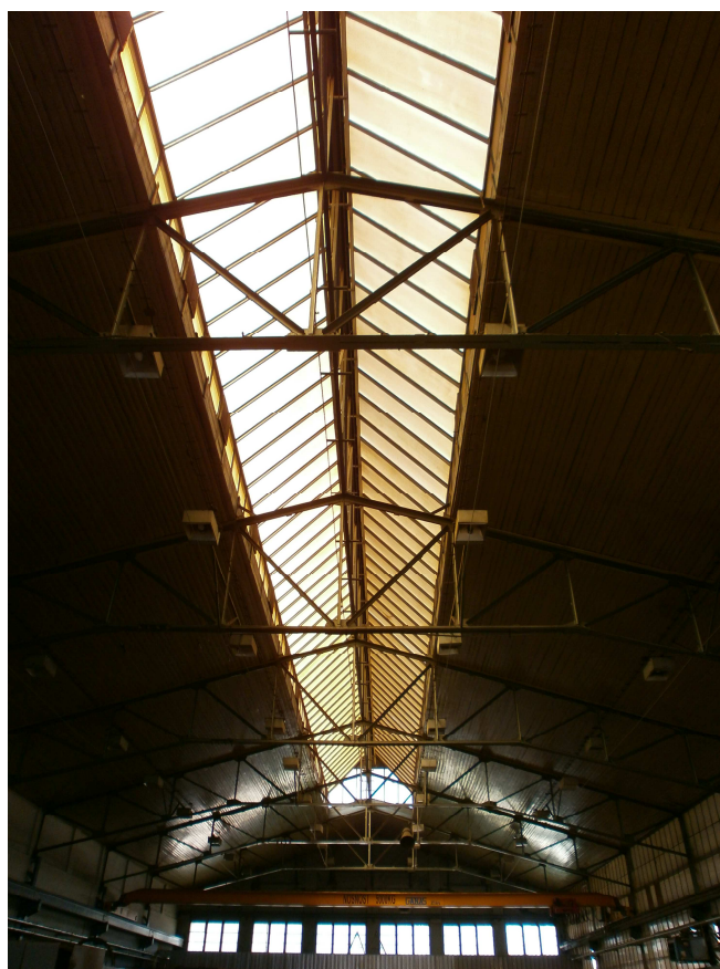
Obrázek 18 Špinavá okna [vlastní zpracování]
