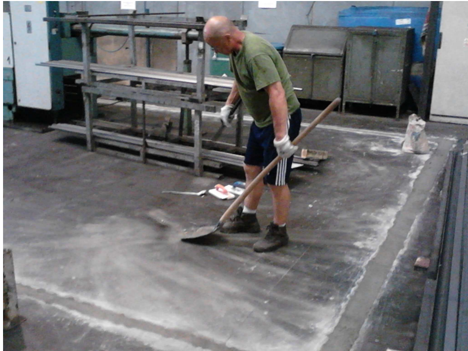
Obrázek 42 Betonování a úklid díry [vlastní zpracování]
