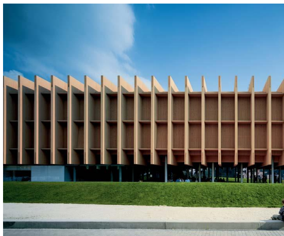
Obr. 57. Pohled na boční stěnu pavilonu
