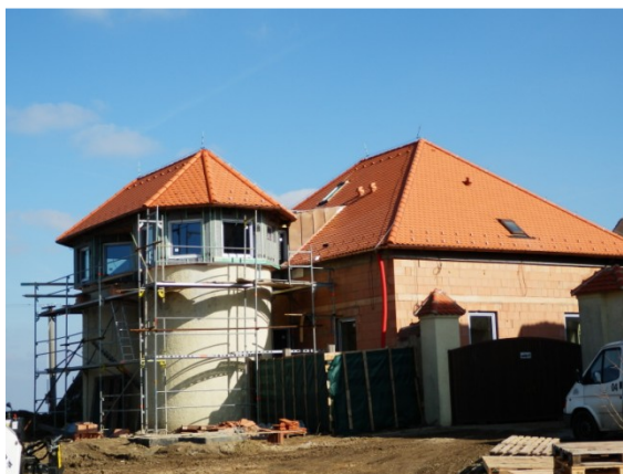
Obrázek 17 Ukázka realizace střechy (fotoarchiv TESALIS s.r.o.)
