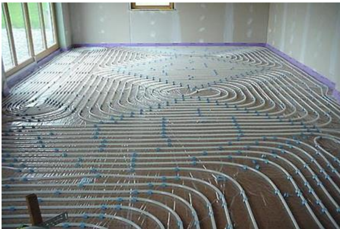
Obr. 5. Trubky v podlahovém vytápění [23]
