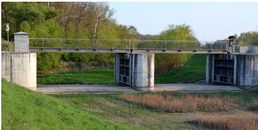
Obrázek 4 Regulační objekt na odlehčovacím rameni Kyjovky
