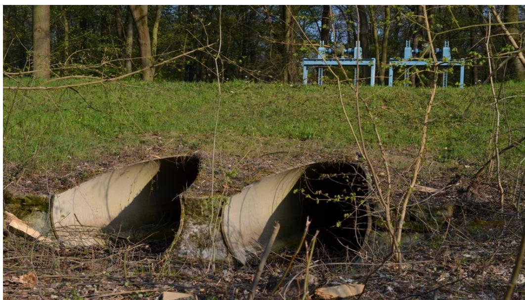
Obrázek 5 Hrázová výpust' – Očovská hráz [Zdroj vlastní]
