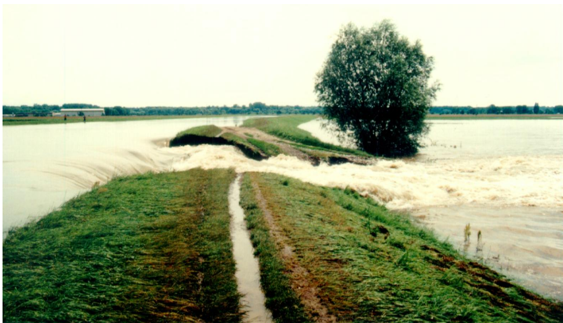
Obrázek 2 – Protržená hráz odlehčovacího kanálu mezi Kyjovkou a Moravou [Zdroj Ivo Cencinger]
