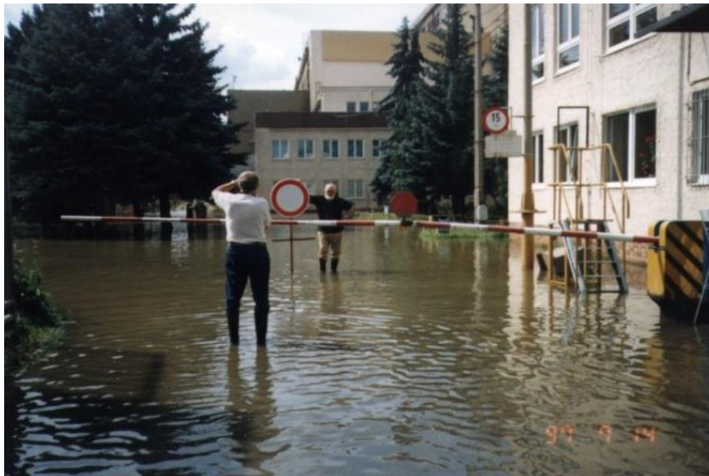
Obrázek 9 – Zaplavená Elektrárna Hodonín v roce 1997
