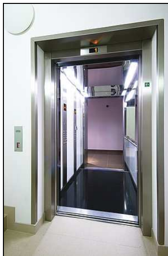
Obr. 1 Požární výtah Zdroj:
