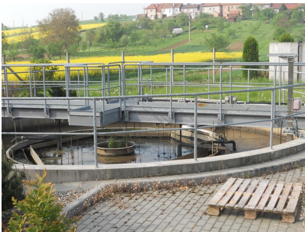
Mechanicko – biologická čistírna odpadních vod v obci Traplice
