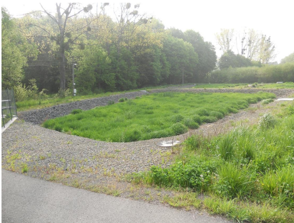
Kořenová čistírna odpadních vod v obci Košíky
