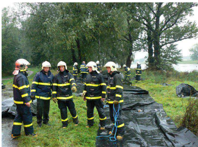
Obr. 15. HZS v akci - budování nafukovacích protipovodňových hrází na břehu Ostravice. [17]
