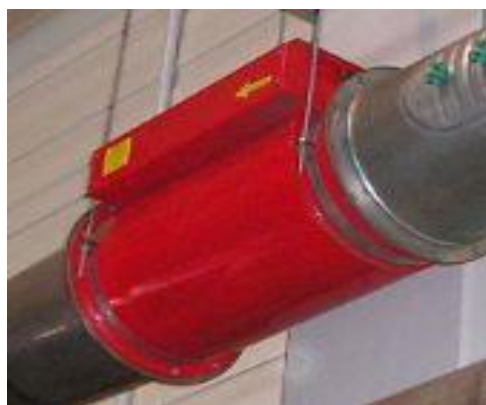
Obr. 10. Zpětná bezpečnostní klapka proti šíření výbuchu. [18]
