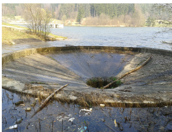
Obr. 9: Funkční blok přelivný
