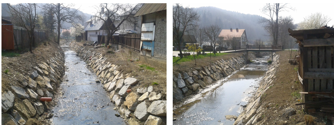
Obr. 13: Rekonstruované koryto potoka Všeminka
