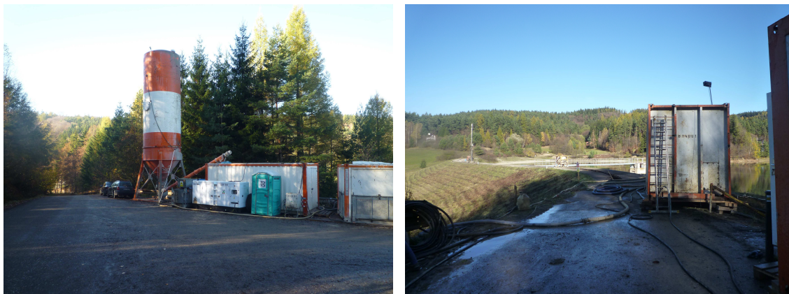
Obr. 15: Rekonstrukce hráze nádrže č. 1
