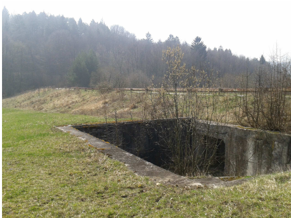
Obr. 10: Hráz a funkční blok přelivný
