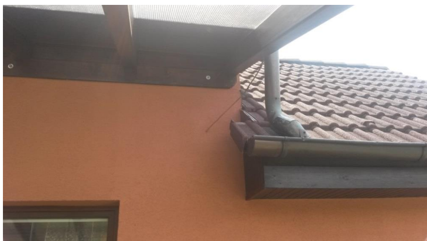
Obrázok 18 Inštalácia káblov po zateplení
