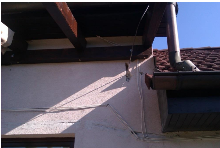
Obrázok 17 Inštalácia káblov pred zateplením
