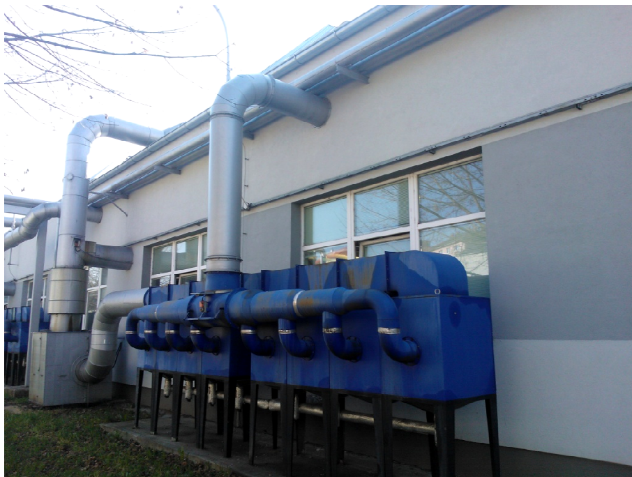
Obrázek 17 Odsávací jednotka s odlučovačem oleje.
