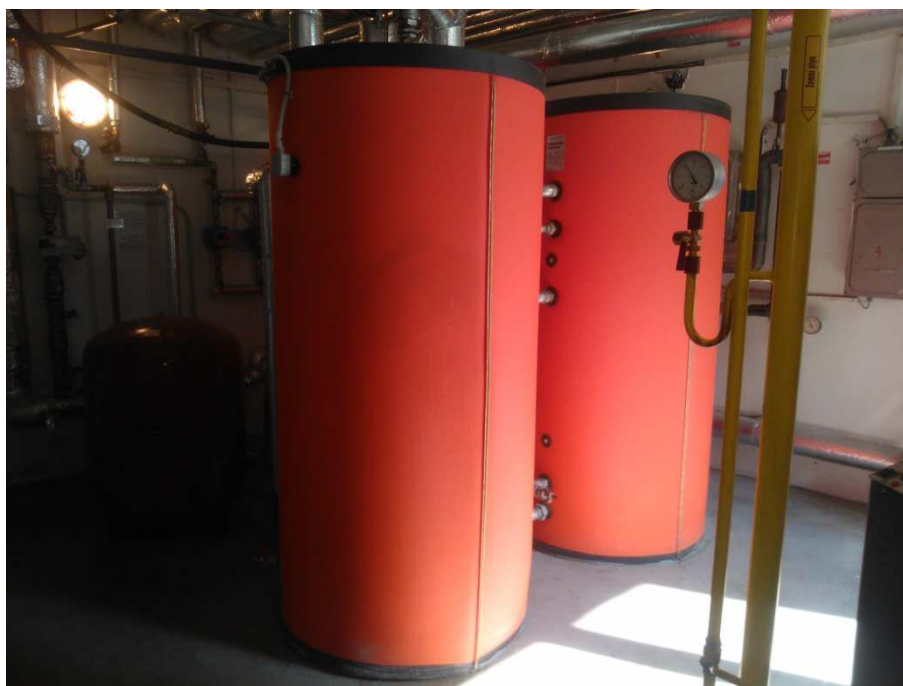
Obrázek 11 Akumulační nádrže teplé užitkové vody.
