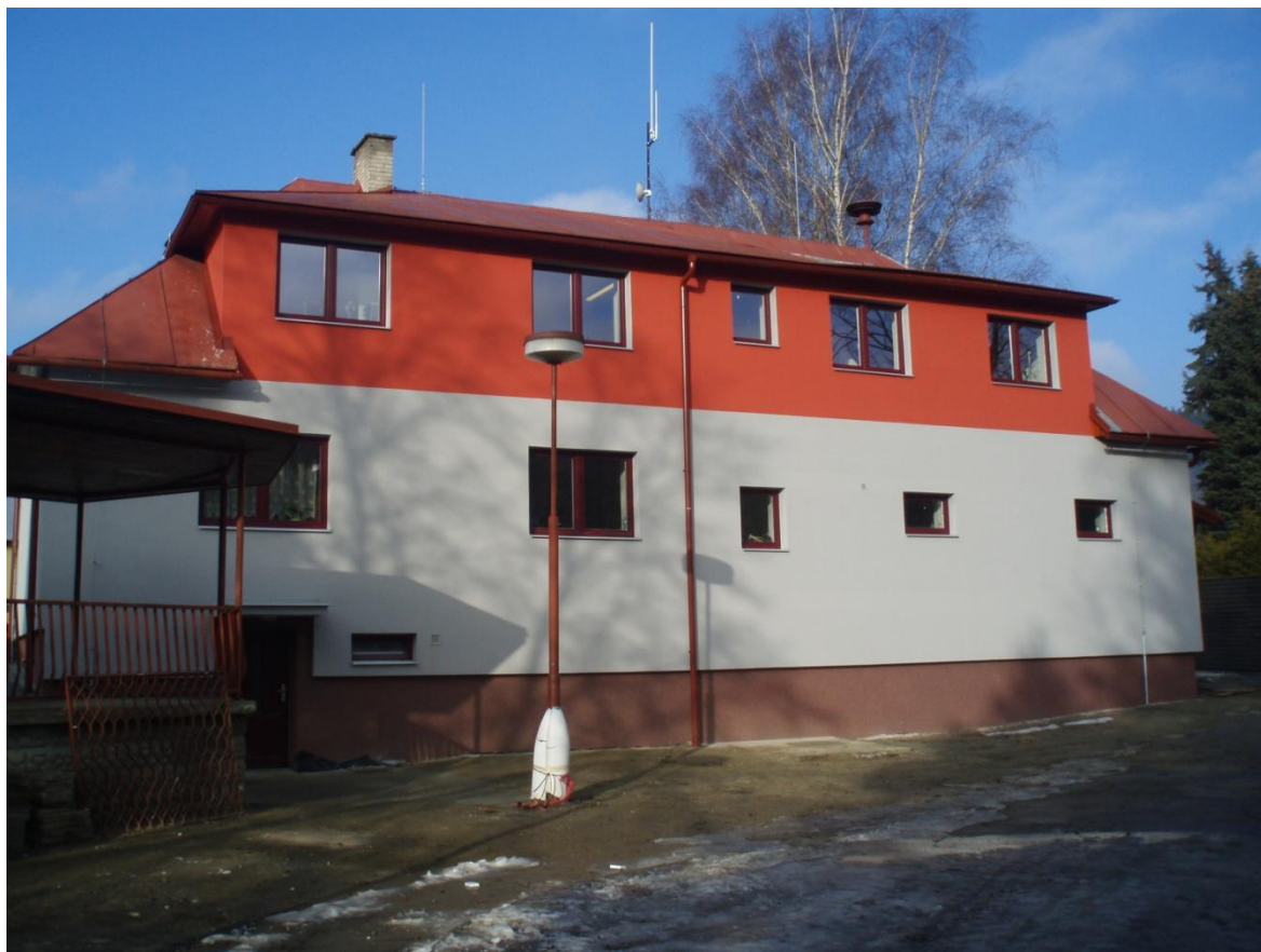
Obr. 7. Zateplení obecního úřadu (zadní strana)
