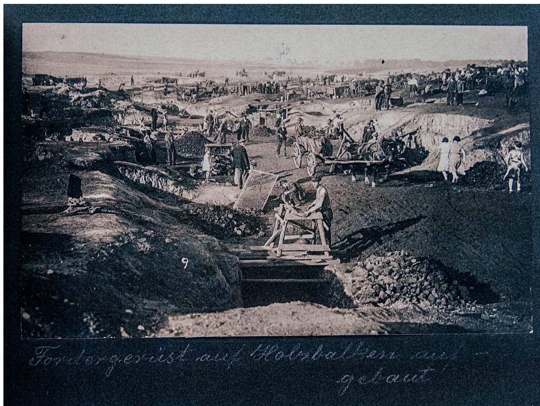
Biedaszyby - „Fördergerüst auf Holzbalken aufgebaut“, 1928, Max Steckel
