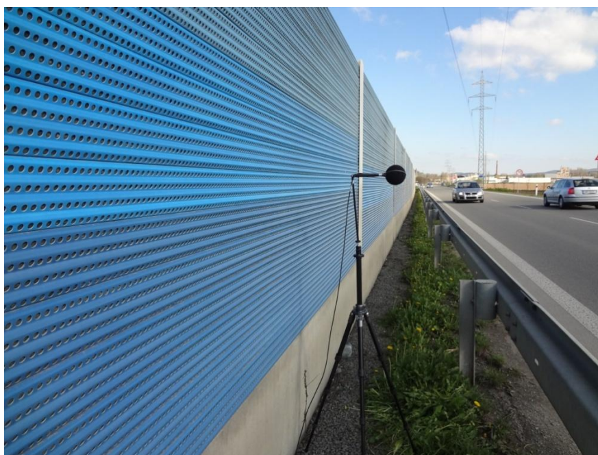
Obr. 11. Umístění mikrofonu silnice č. 374 u Ráječka směr Blansko
