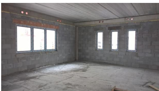
Obr. 3. pohled severovýchodní (ložnice)
