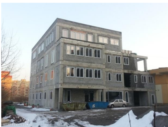
Obr. 1. Současný stav budovy
