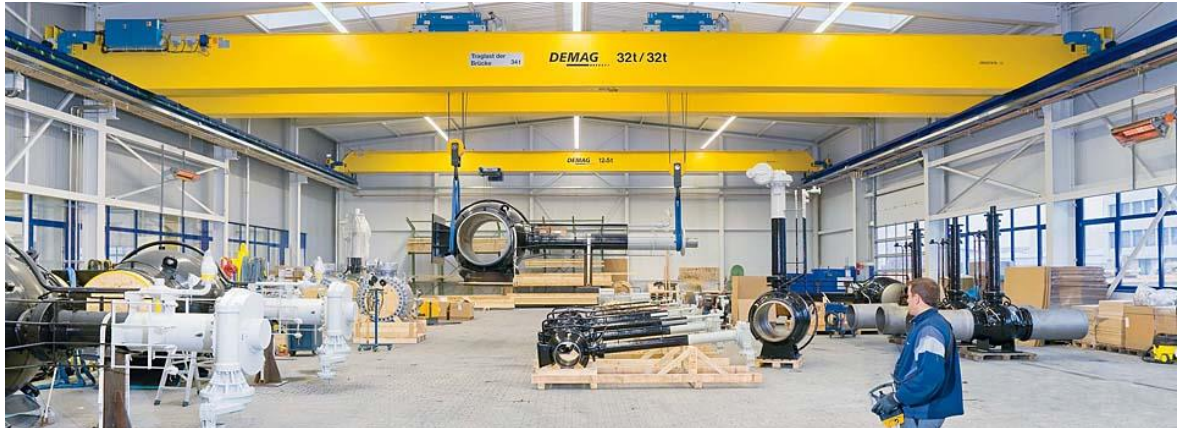
Obrázek 5 – Portálový jeřáb (Adamec Crane Systems, 2015)
