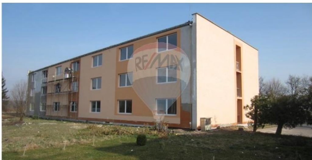
Obr. 3 Ubytovací zařízení Čankovice, zdroj: (sreality.cz, ©2015b)
