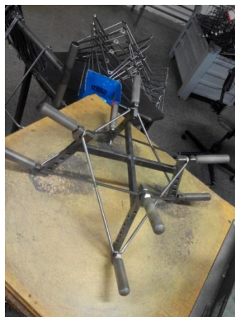
Obrázek 29 Montáž dvou konstrukcí (vl. foto)
