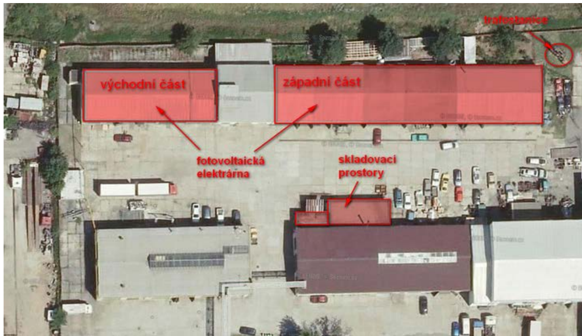
Obr. 19 - Letecký pohled na střezené objekty
