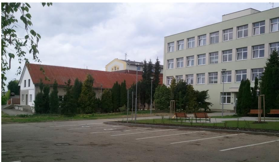
Obr.: 18 Pohled z jižní strany na Domova se zvláštním režimem
