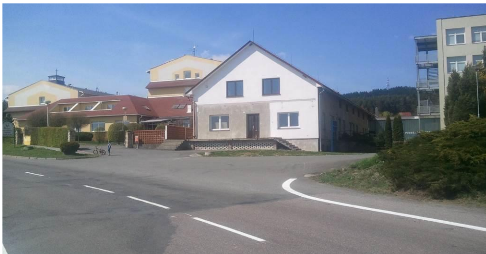
Obr.: 23 Oblast bez perimetrické ochrany areálu na jižní straně
