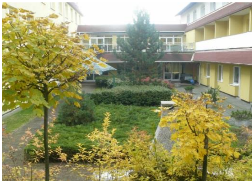
Obr.: 17 Pohled ze severní strany na Domova pro seniory
