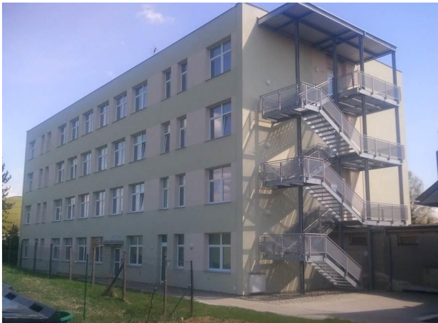
Obr.: 19 Pohled ze severní strany na Domova se zvláštním režimem
