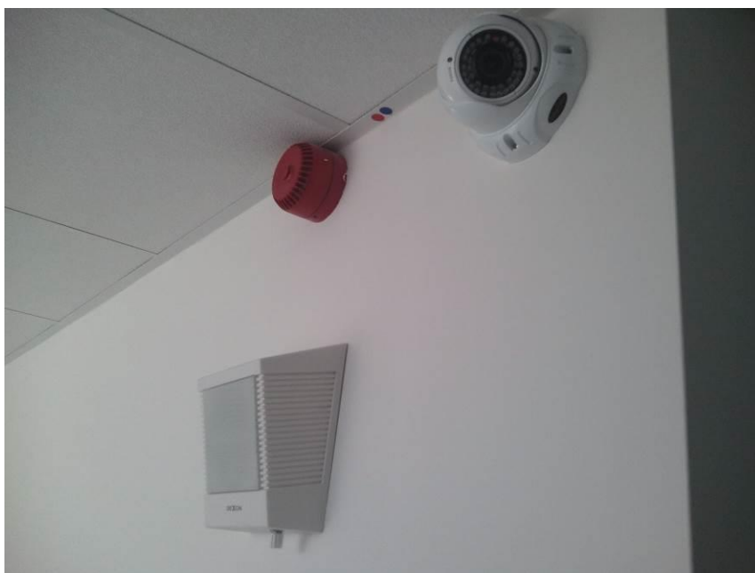
Obr.: 24 Vnitřní kamera se sirénou a rozhlasem
