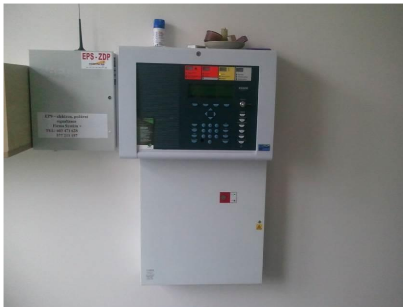
Obr.: 25 Ústředna EPS v DZR
