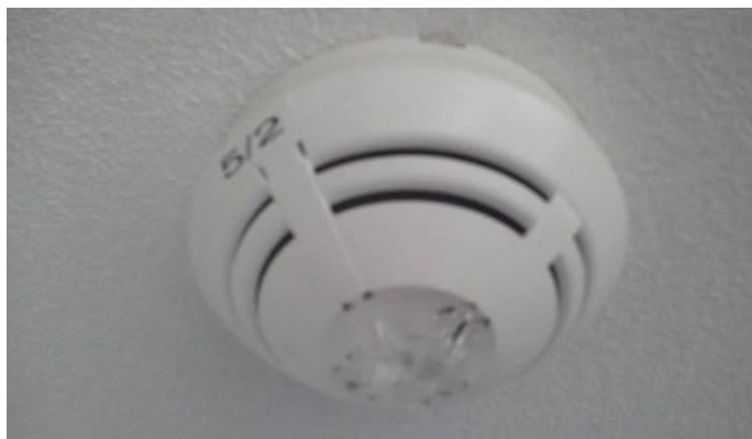
Obr.: 26 Interaktivní opticko-kouřový hlásič v budově DZR
