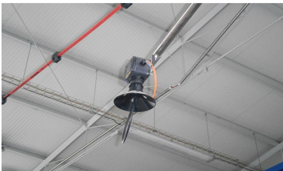
Obr. 13. Plynový detekční systém používaný v prostorách kompresoroven v PZP.
