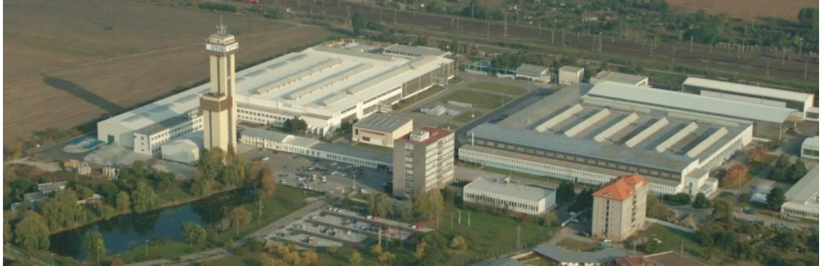
Obrázek 9 Areál divize Escalators OTIS a.s. v Břeclavi [25]
