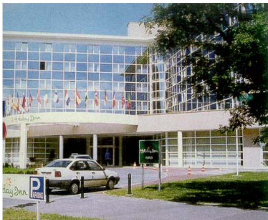
Obrázek XIII – Vstupní část hotelu Holiday Inn (výstavba po roce 1989)
