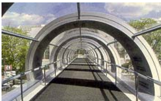
Obrázek XV – Pasarel mezi pavilony B a E Holiday Inn (výstavba po roce 1989)
