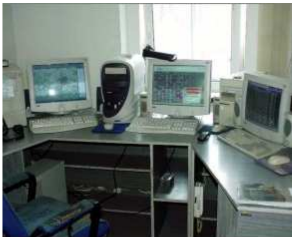
Obr. 1. Pult centralizovanej ochrany (10)
