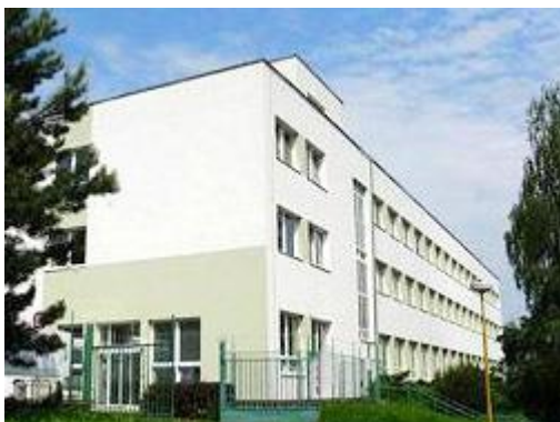
Obrázek 11 Nástrojárna a administrativní budova (OBZOR, 2015)
